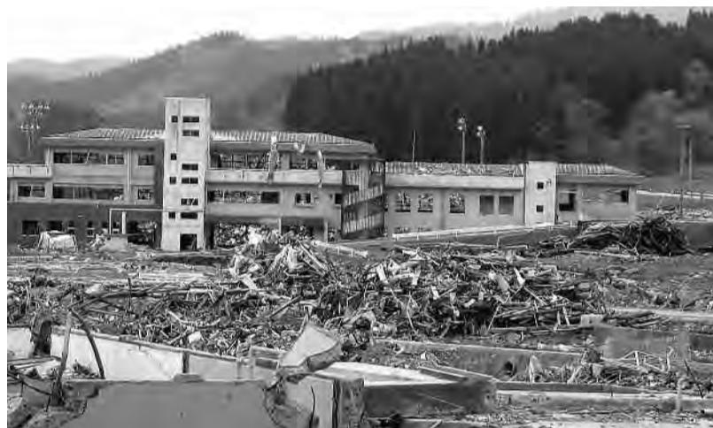
校舎は破壊されたが、生徒たちは3カ月前に完成の非常通路から高台に逃げて無事だった大船渡市の越喜来（おきらい）小学校
