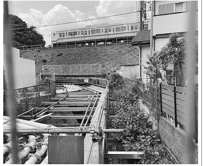
東京地裁は昨年2月、住民の仮処分申請を認め、気泡シールドマシンによる工事の本線南側60%の掘削を差し止める決定を下し、今年7月7日付で最高裁も、上告棄却でこれを確認する形となった。
