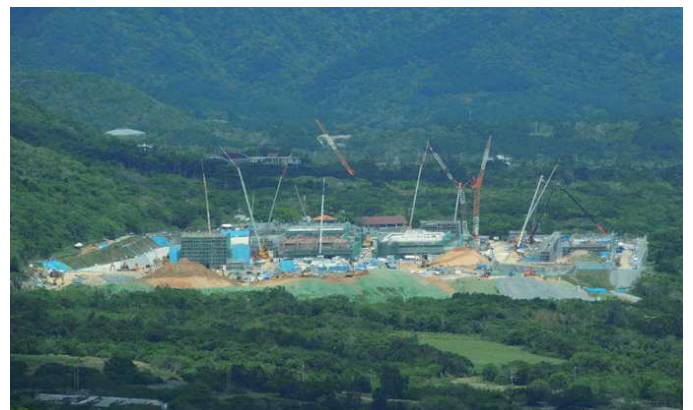
建設途中の石垣駐屯地（2022年9月30日撮影）
