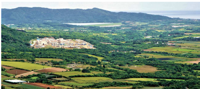
急ピッチで工事が進められていた陸上自衛隊石垣島駐屯地。緑豊かな於茂登岳の山麓に白く浮かび上がっていた=2023年1月28日
