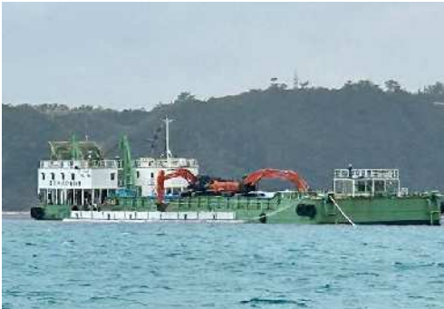
👉 台船から投入される石材
