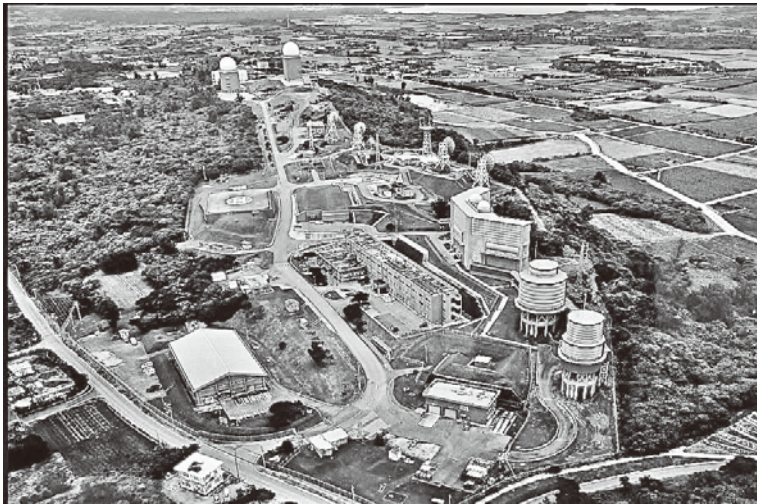
航空自衛隊宮古島分屯地レーダー基地
